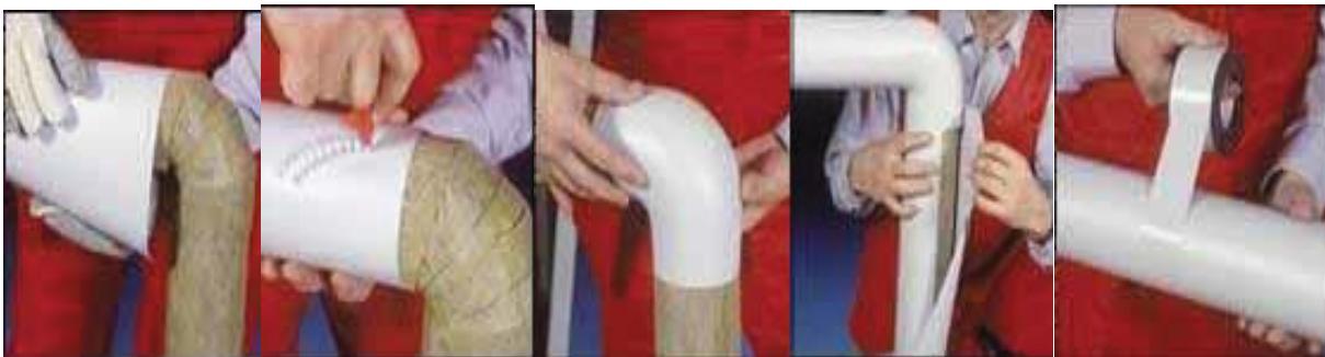
Obr. č. 3. Montáž PVC opláštenia
